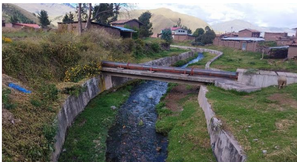
FIGURA N°03: TRAMO CON DEFENSA RIBEREÑA CON MURO DE CONCRETO EN AMBAS MARGENES DEL RIO MANCURA Y SE APRECIA CAUCE COLMATADO.
